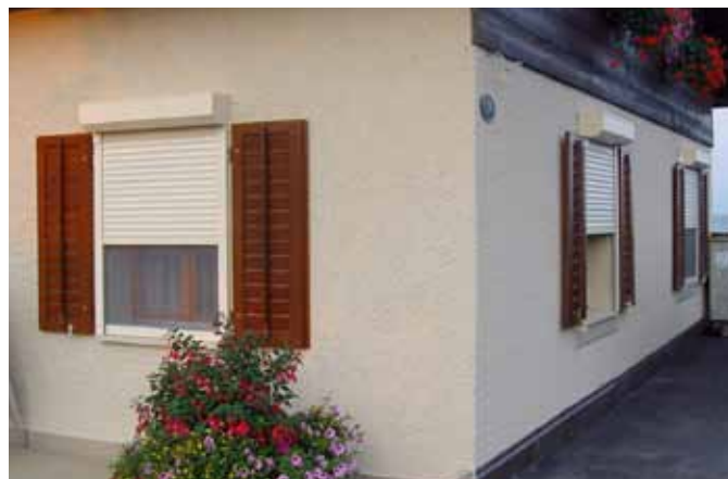
MONTFIX, Sanierung Einfamilienhaus
